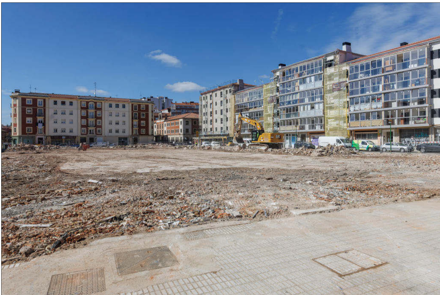
Una máquina retira estos días los últimos restos de la demolición del edificio que se construyó en 1950. SANTI OTERO
